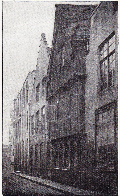
Bruges. — Maison de bois rue Cour-de-Gand.
