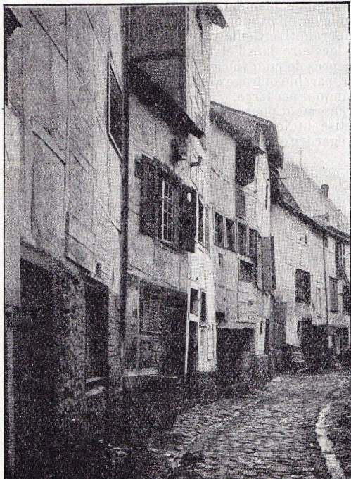
Stavelot. — Vieilles maisons ouvrières.
